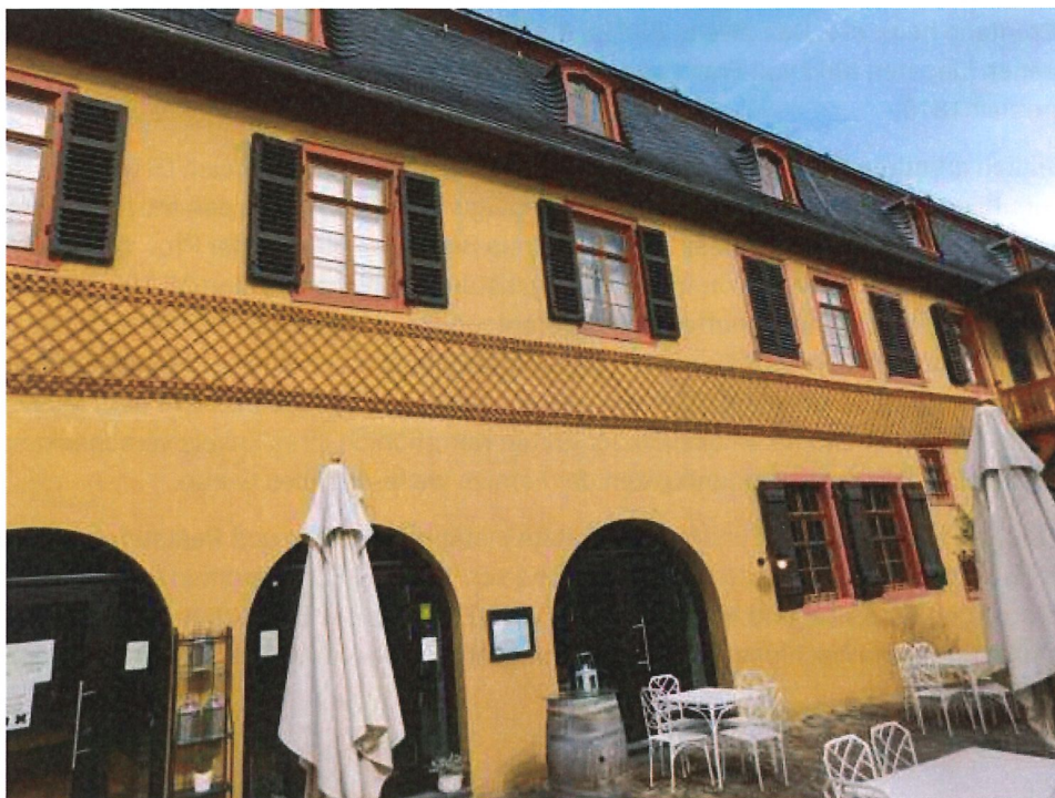
Ein Blick auf die renovierte Fassade, Fenster und Dach
